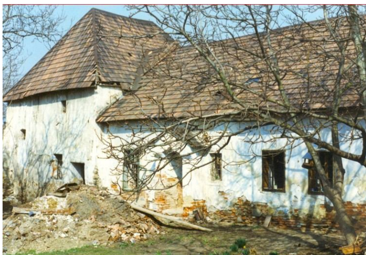
Stav objektu pri zahájení obnovy
