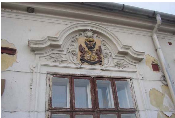
Detail vstupného portálu pred rekonštrukciou
