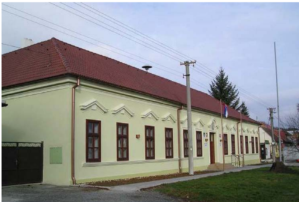
Celkový pohľad na objekt po obnove
