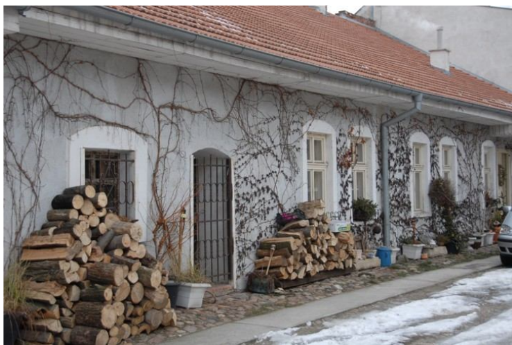
Detail fasády objektu, vstup do ateliéru
