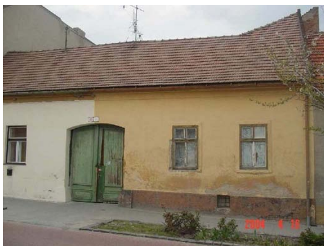
Uličná fasáda pred rekonštrukciou, apríl 2004
