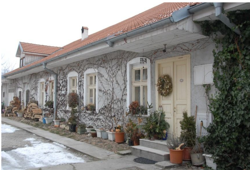
Fasáda objektu, pohľad z dvora
