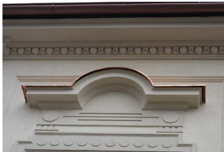
Detail nadokennej a korunnej rímsy
