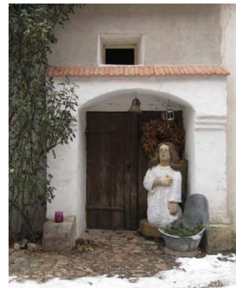
Vstup do plytkej pivnice
