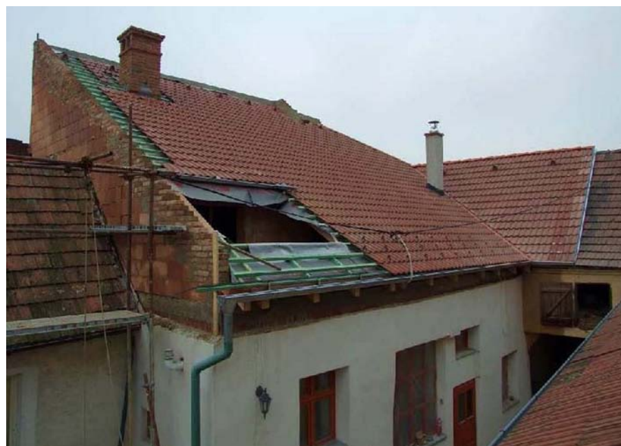
Rekonštrukcia podkrovia, november 2009
