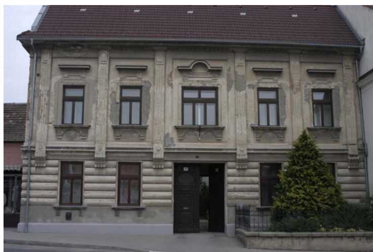
Pohľad na objekt pred obnovou
