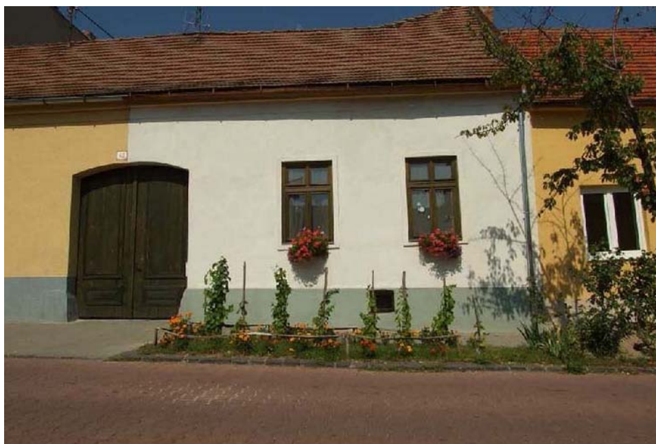
Uličná fasáda po rekonštrukcii, august 2009
